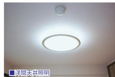
天井照明は、調光調色タイプのLEDシーリングライトに変わります。電球色~昼光色、常夜灯など、リモコンで操作できます。
