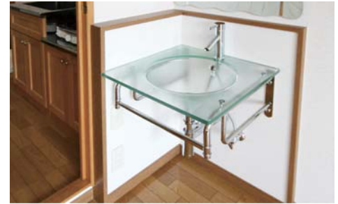
■ガラス洗面 (一部設置)
