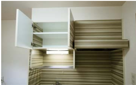
■システムキッチン上部
